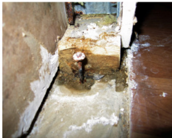
4. Avdekking av skadested inn mot dusjnise.
