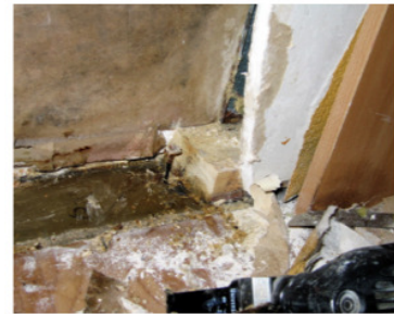
3. Avdekking av skadested inn mot dusjnise.
